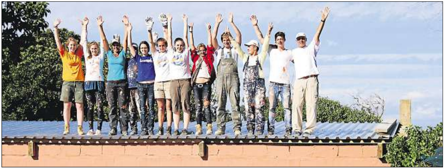
Im Oktober war eine Schulklasse aus Hamburg in Südafrika und hat dort das Gebäude aufgebaut, in dem die Schreinerwerkstatt von Harald Schneider untergebracht werden soll. (Foto: privat)
